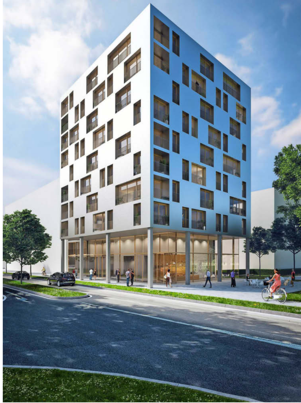
Wegweiser in die Zukunft: Das zehnstöckige Hochhaus Skaio ist bis auf das Sockelgeschoss fast komplett aus Holz gebaut. Die Fassade wird mit Aluplatten verkleidet.
